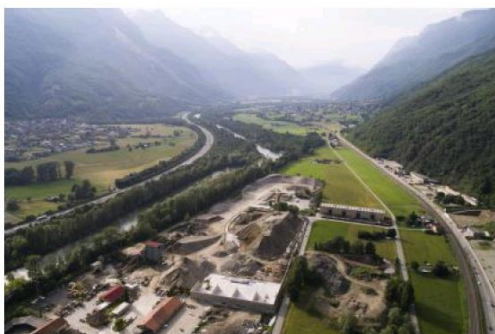
Il sedime per il nuovo stabilimento
